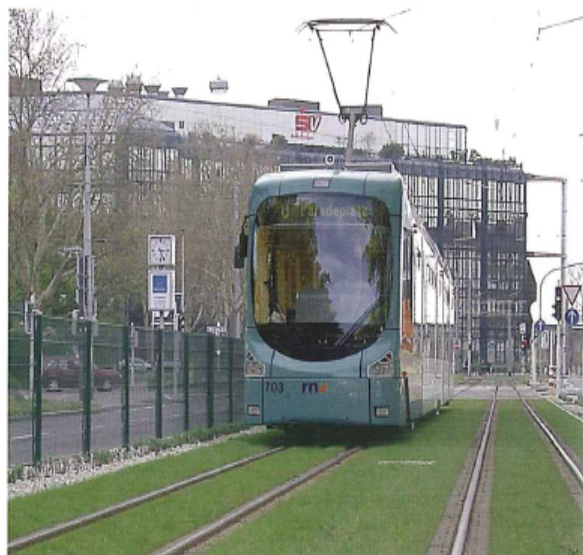
Mit dem vielfach verbauten Fahrbahnsystem »TRAVETTO-INPLACE« steht den Verkehrsbetrieben ein kostengünstiges »FF-System« zur Verfügung. Durch die Verwendung entsprechender Schienenzusatzkomponenten eignet es sich für alle üblichen Eindeckvarianten, beispielsweise für ein Rasengleis (rechts).
