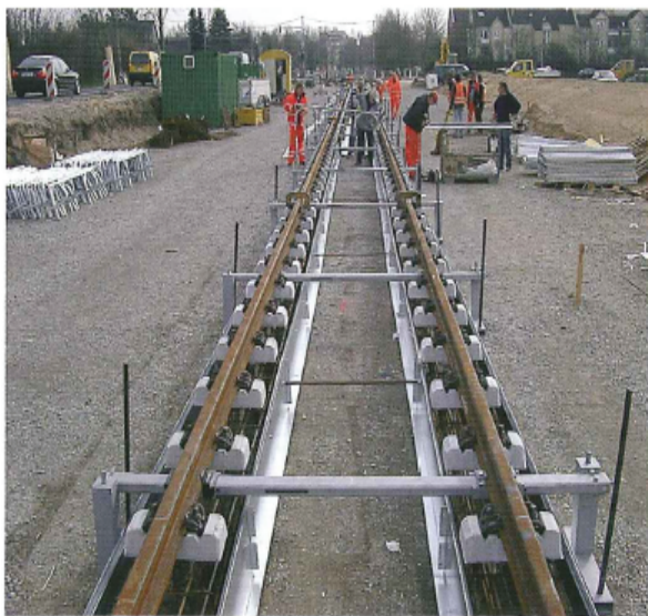
Mit dem vielfach verbauten Fahrbahnsystem »TRAVETTO-INPLACE« steht den Verkehrsbetrieben ein kostengünstiges »FF-System« zur Verfügung. Durch die Verwendung entsprechender Schienenzusatzkomponenten eignet es sich für alle üblichen Eindeckvarianten, beispielsweise für ein Rasengleis (rechts).
